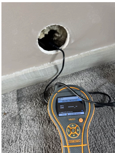
Hull mot våtrom fra soverom i 2. etg.
