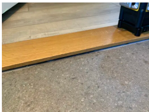
Terskel dør bad hovedetasje.
