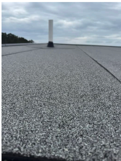
Tak over 3 etasje tekket med takpapp
