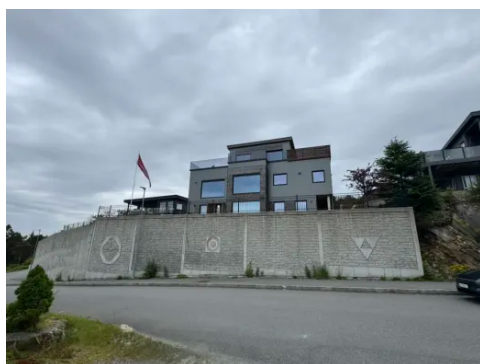
Oversikt støttemur front bolig
