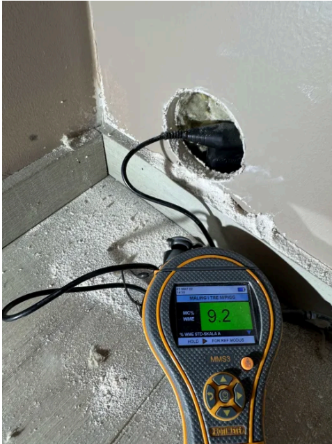
fuktmåling under trapp i U.etg.
