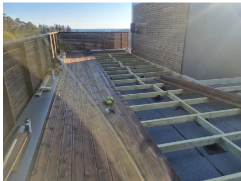
Bilde 1: fra oppføring av terrasse på tak. Viser konstruksjon
