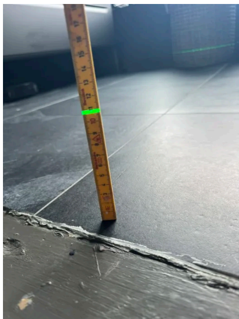
måling ved flat dørterskel som flukter med flisegulv. (TG 3)
