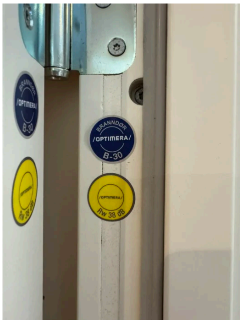
Dør fra vaskerom til garasje B-30
