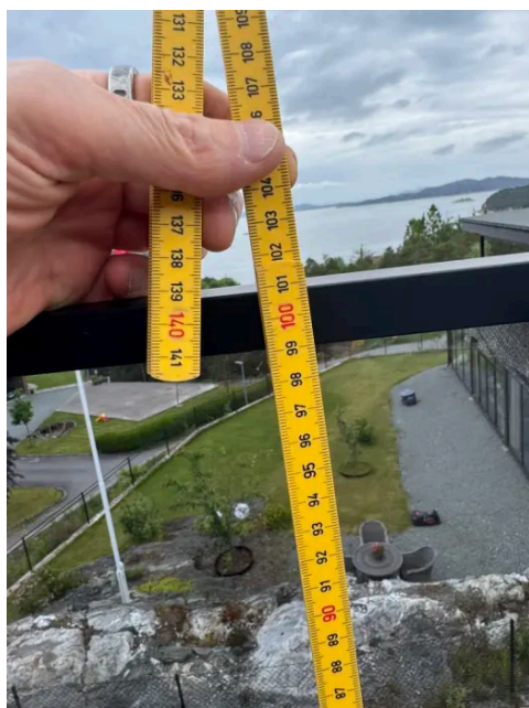
Målt høyde glassrekkverk i front av terrasse, foran soverom over 2 etasje. 101 cm.
