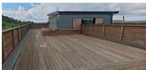
Takterrasse på befaringdagen
