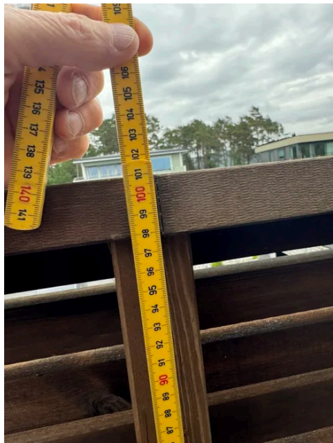
målt høyde rekkverk av tre på hoveddel av terrasse. 101 cm.
